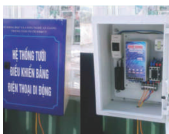
Hệ thống tưới phun sương nhà nấm tự động theo cảm biến ẩm độ
